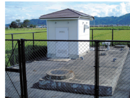
写真4-10-2 ポンプで送られてきた農業用水を農地へ分水する施設
